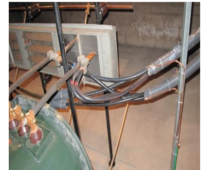
Lỗi lắp đặt
